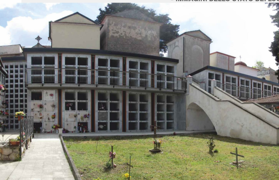
vista d'insieme dell'intervento di rifacimento loculi dal piano inferiore del cimitero
