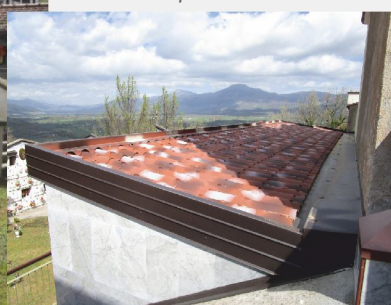
copertura lato ovest
