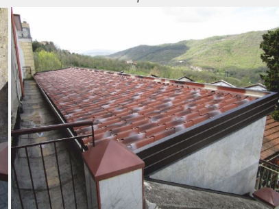
copertura lato est
