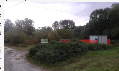
lavori sulla rete acquedottistica
