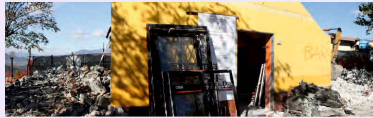
Immagine della demolizione parziale dell'edificio già adibito a bar, in corso di esecuzione
