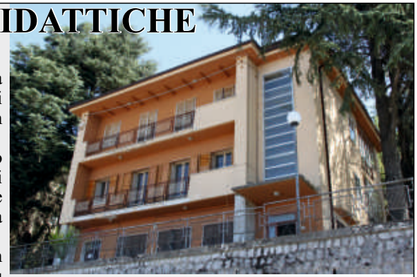
L'edificio della ex Caserma Forestale, al cui primo piano si sono temporaneamente trasferite le attività didattiche della Scuola Media
