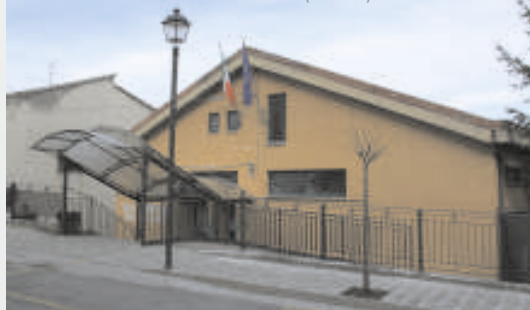
Scuola Elementare (Primaria)
