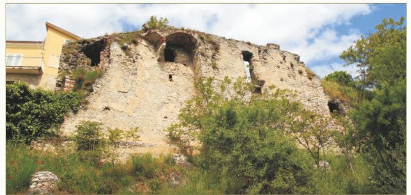
Parete orientale oggetto di parte degli interventi strutturali del progetto
