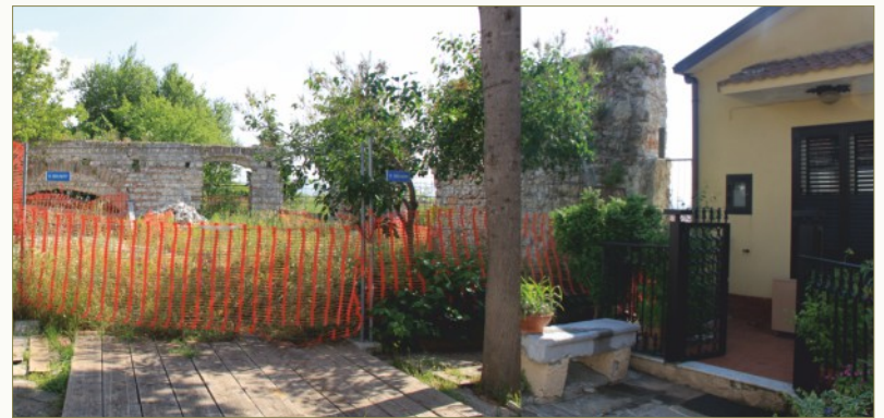
Stato attuale dell'area superiore da sistemare
