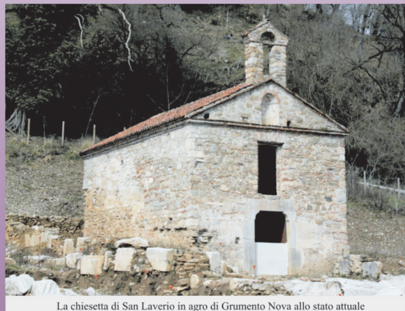
La chiesetta di San Laverio in agro di Grumento Nova allo stato attuale
