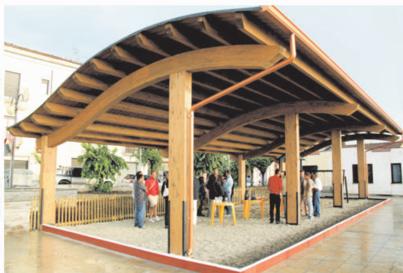
La struttura in legno lamellare sul belvedere panoramico allo stato attuale
